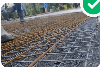
Pavimentos de concreto
