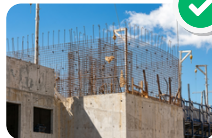
Parede de concreto
