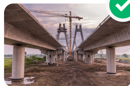
Pontes e viadutos
