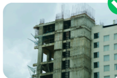
Parede de Concreto
