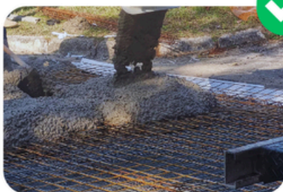
Pavimentos de concreto
