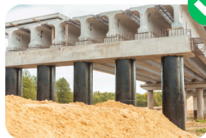
Pontes e viadutos
